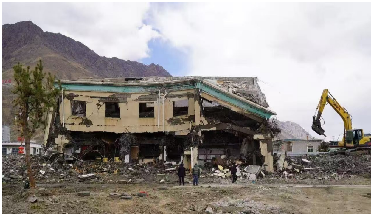
图为乃东区城市更新第三批集中拆除现场。
