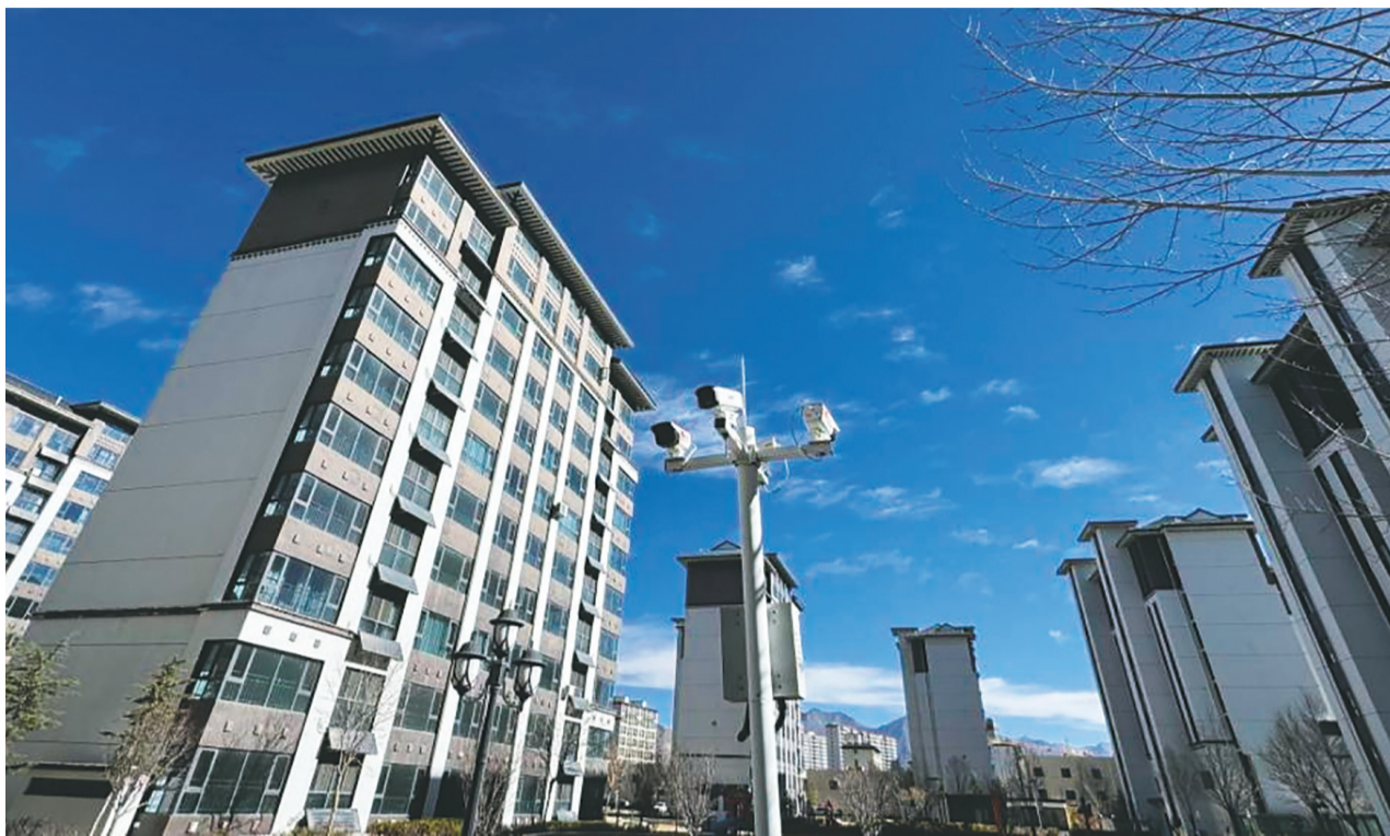
图为杜鹃苑小区的视频监控摄像头。
