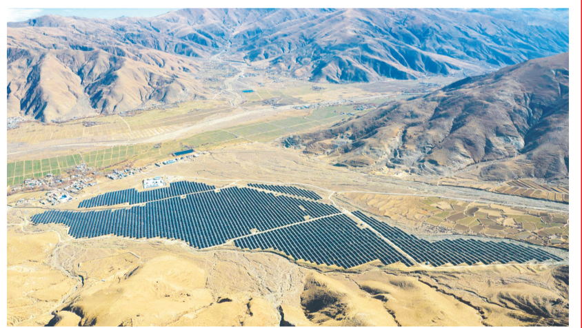
图为扎囊县罗堆村50MW光伏治沙示范性项目现场。
