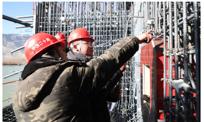
图为工人正在检查焊缝。
