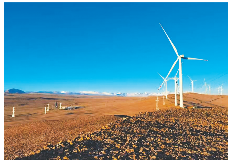
图为三峡美哲古风电项目现场。
