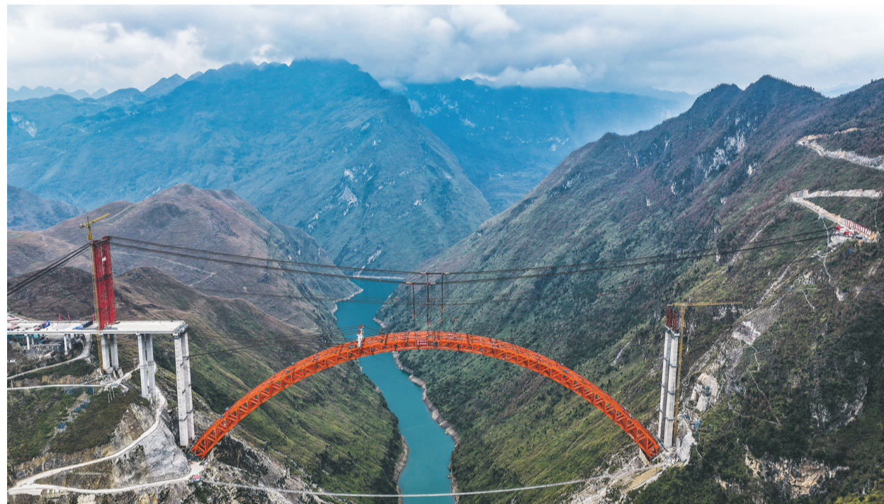
1月5日拍摄的安盘高速古牛河特大桥合龙现场(无人机照片)。 1月5日,随着最后一节钢拱精准吊装到位,贵州交投集团承建的安顺至盘州高速公路古牛河特大桥顺利合龙,为后续工程建设推进奠定了坚实基础。古牛河特大桥是安盘高速控制性工程,全长881.8米,主桥横跨古牛河,主桥桥面到谷底高度约400米。 新华社记者 陶亮 摄
