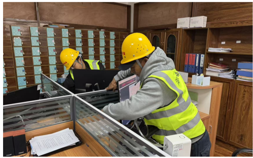
图为工人正在安装供氧设备。
