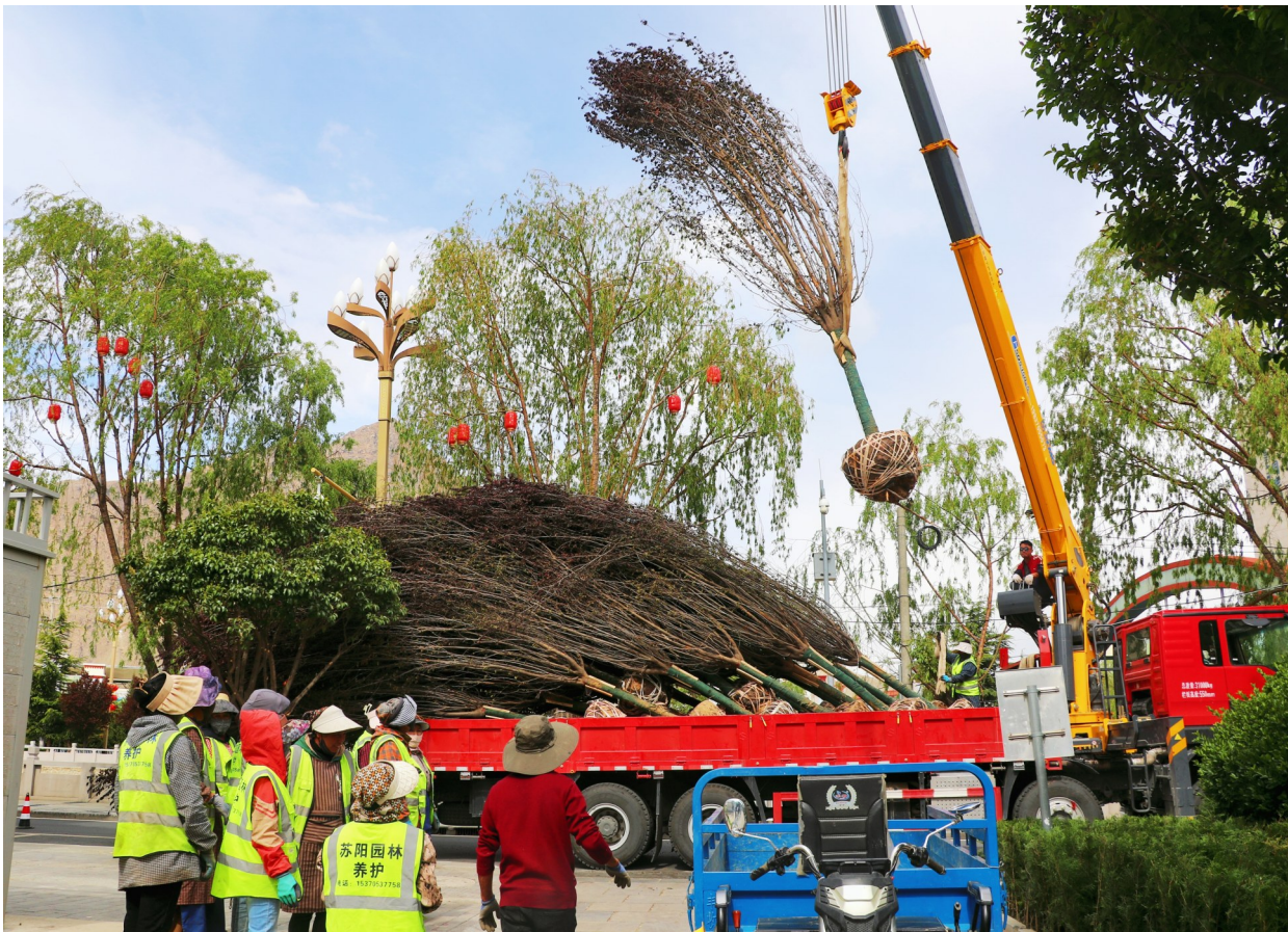
图为香曲东路绿化工人合力将苗木搬运到栽种区。
