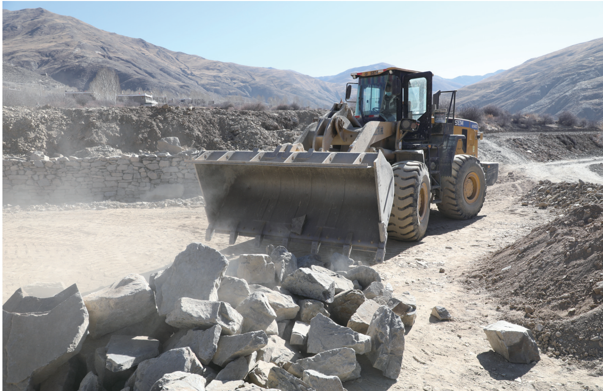
图为扎囊县吉汝乡雪拉村高标准农田建设现场，大型机械在田间来回穿梭、有序作业。
