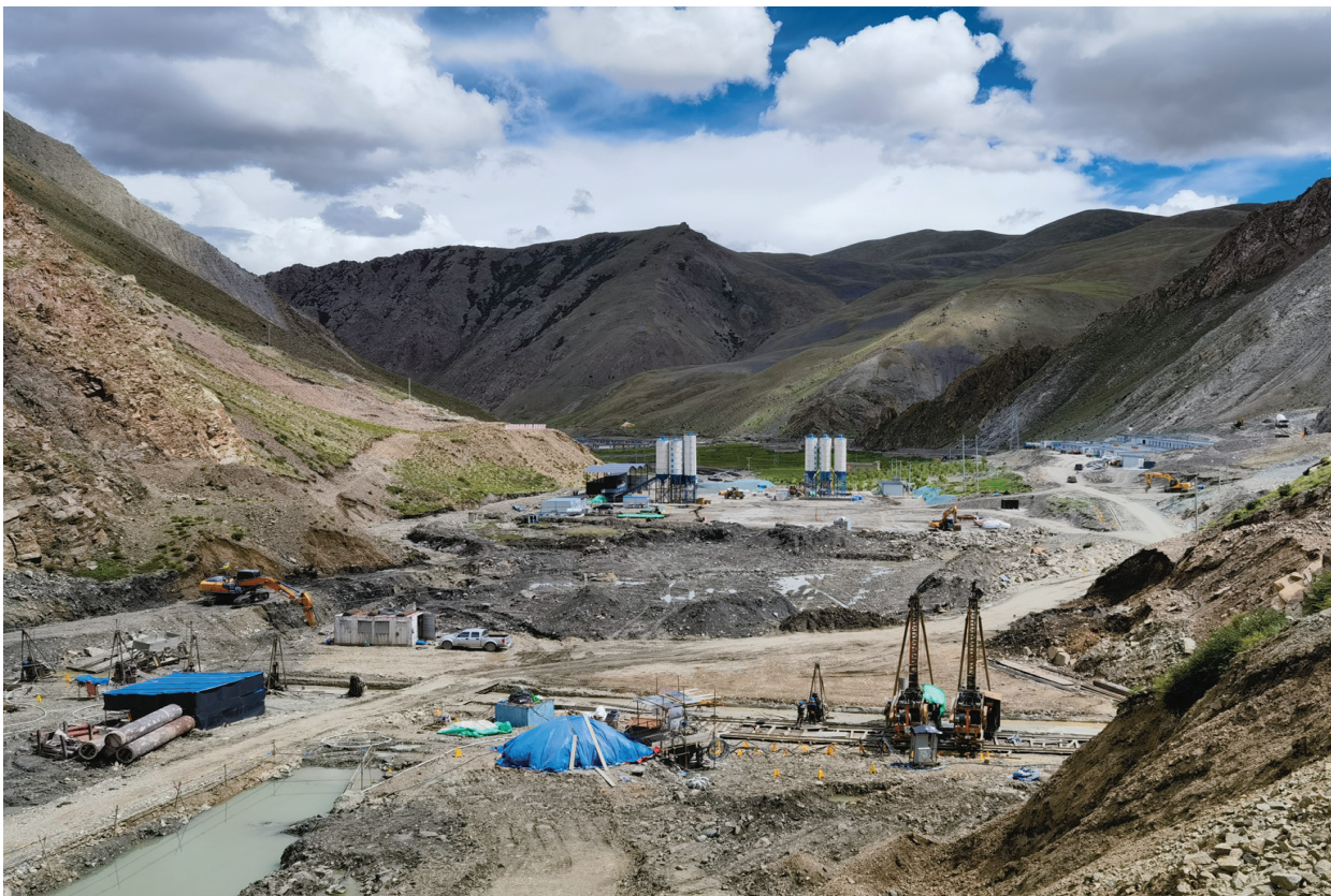
图为措美县下巴水库施工现场。
