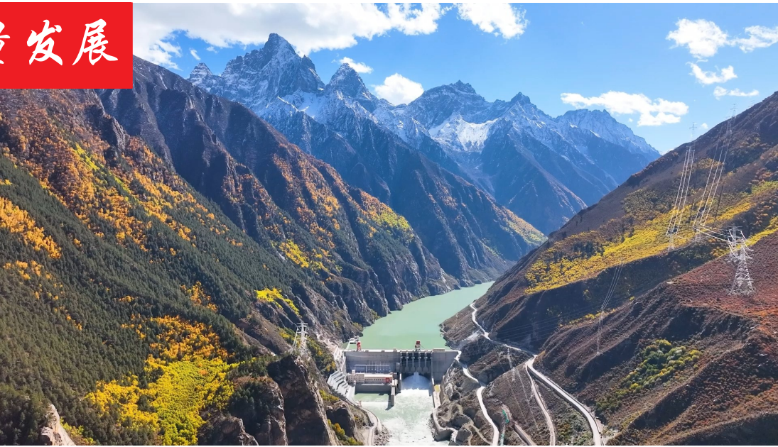
图为华电西藏DG水电站项目。
