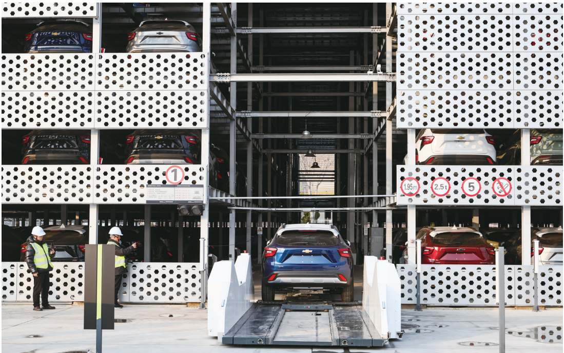
12月27日,在山东港口烟台港,车辆通过全地形智能转运装备运送至商品车智能立体车库。据悉,由山东港口烟台港自主研发的全地形智能转运装备,作业人员减少60%,周转效率提高20%;自主研发的智能立体车库与智能转运装备协同作业系统,堆存能力提升3倍。
