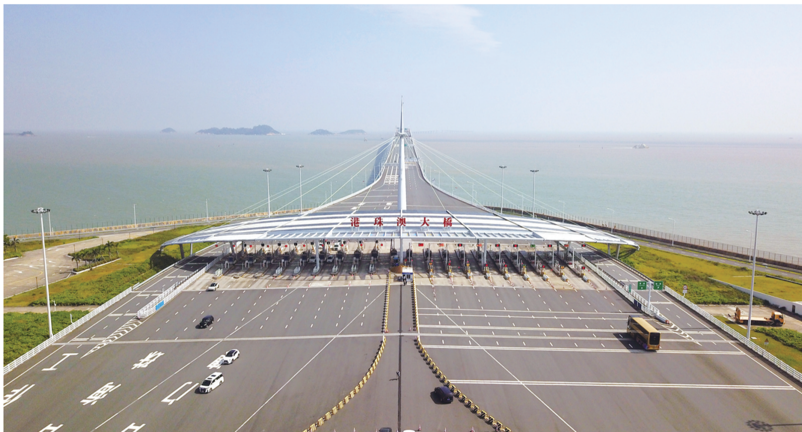
这是10月23日拍摄的港珠澳大桥(无人机照片)。来自港珠澳大桥边检站的数据显示,从2018年10月23日正式开通以来,经港珠澳大桥珠海公路口岸往来粤港澳的人员达3600万人次,车辆750万辆次。今年以来,经港珠澳大桥出入境超过1150万人次,较2019年同期增长6%;出入境车流量达235万辆次,是2019年同期的3.6倍。五年来,粤港澳不断推出更加便利的通行措施。2023年,随着“港车北上”“澳车北上”政策落地,港珠澳“1小时生活圈”基本形成,港澳居民开车“北上”正成为大湾区居民的新生活方式。
