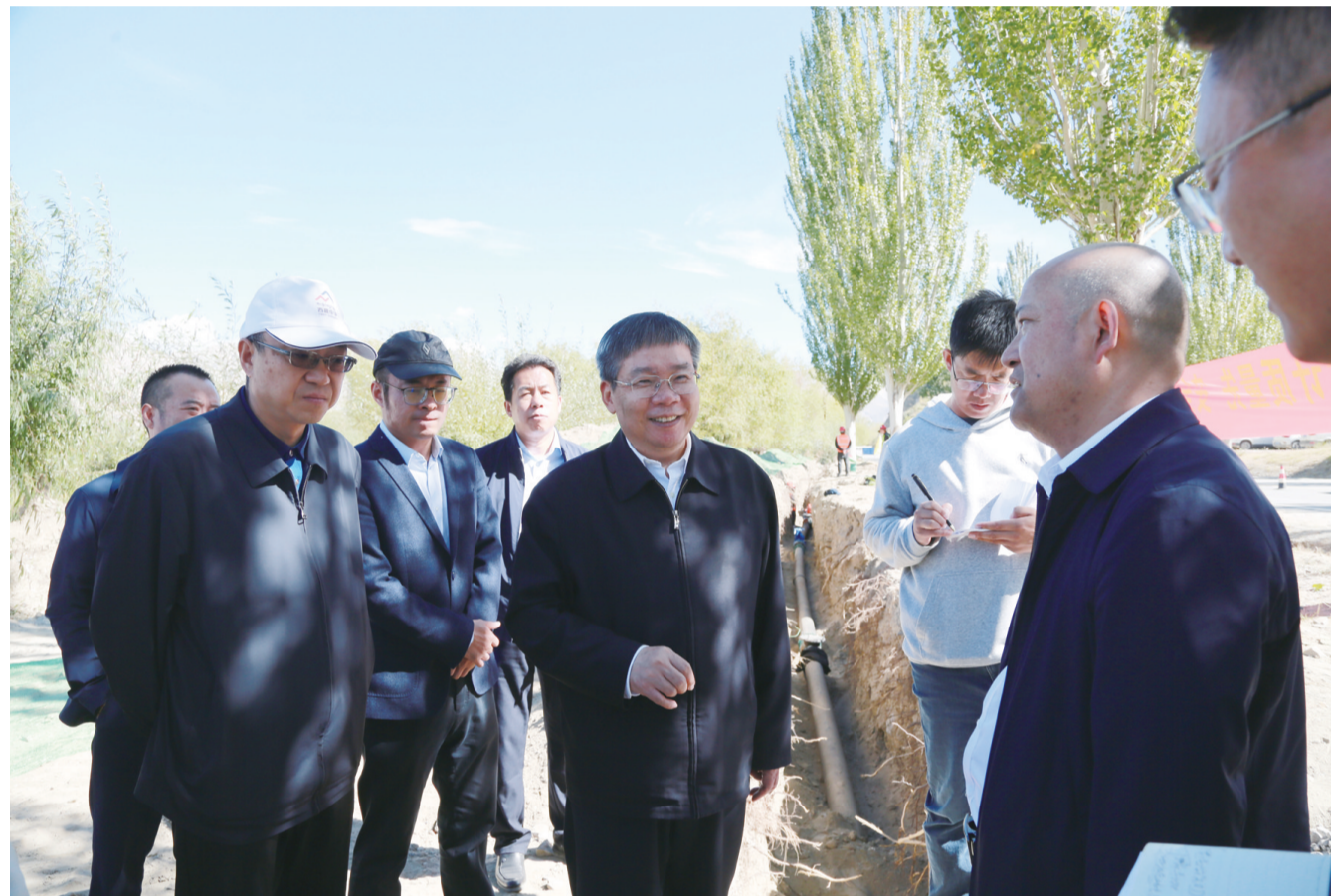
图为许成仓在空港新区污水处理厂及配套管网建设项目（一期）EPC总承包项目建设现场督导检查。
