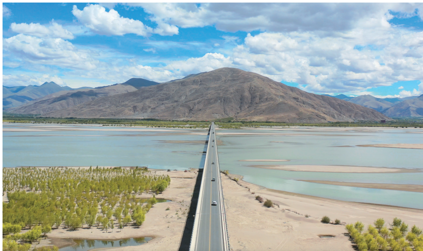
笔直的扎囊特大桥。
