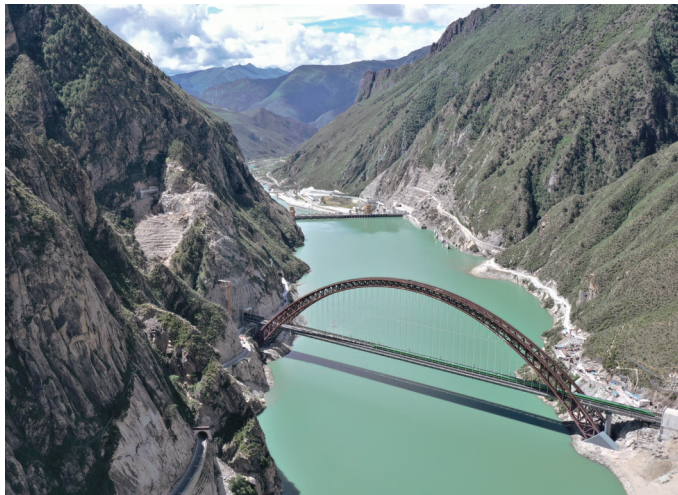
火车正在通过藏木特大桥。
