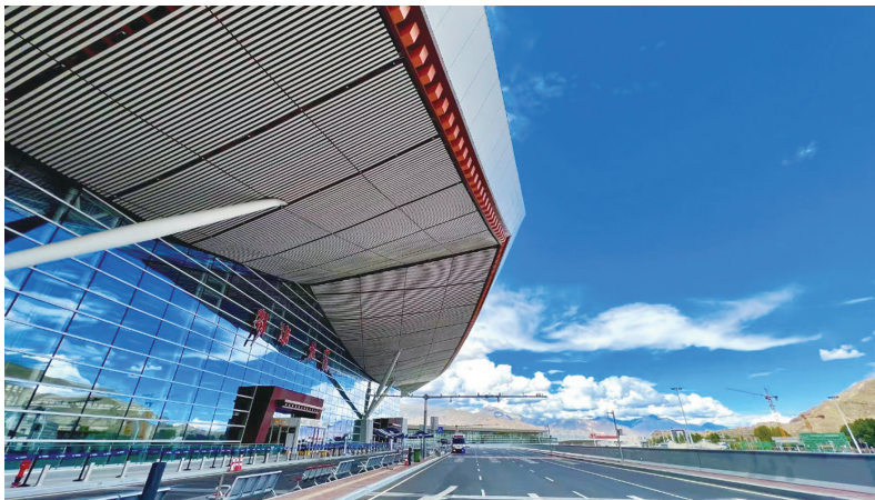
新建的拉萨贡嘎机场T3航站楼。
