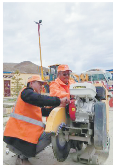
图为尼玛次仁(右)和同事在修理路面切割机。
