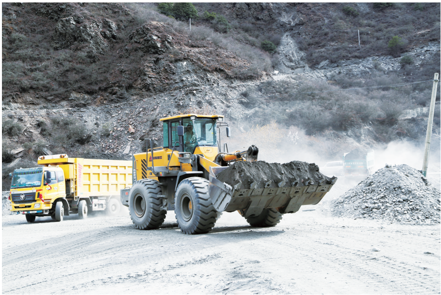
图为隆子县斗玉乡斗玉村砂石场作业现场。
