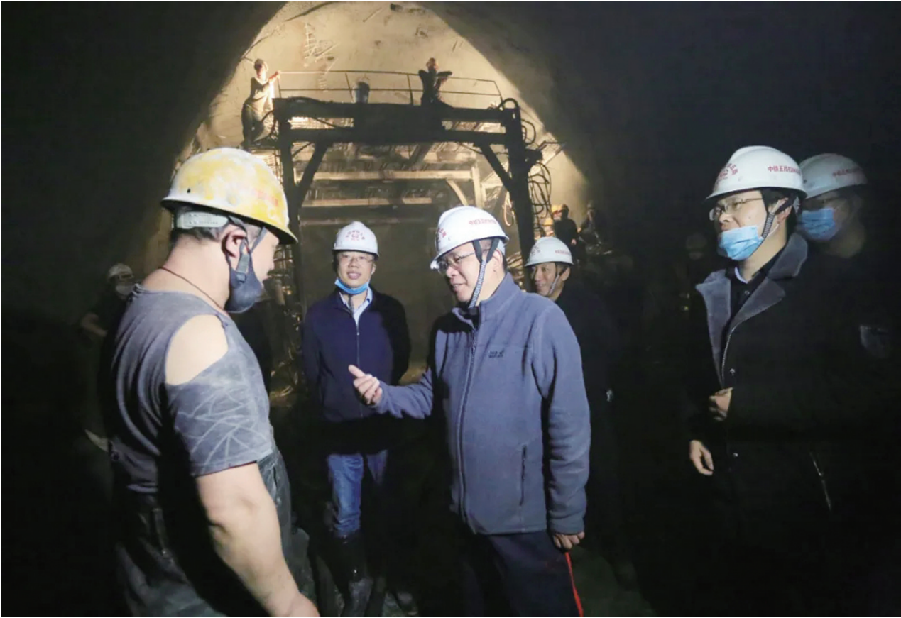
图为许成仓在藏嘎隧道看望慰问施工人员。
