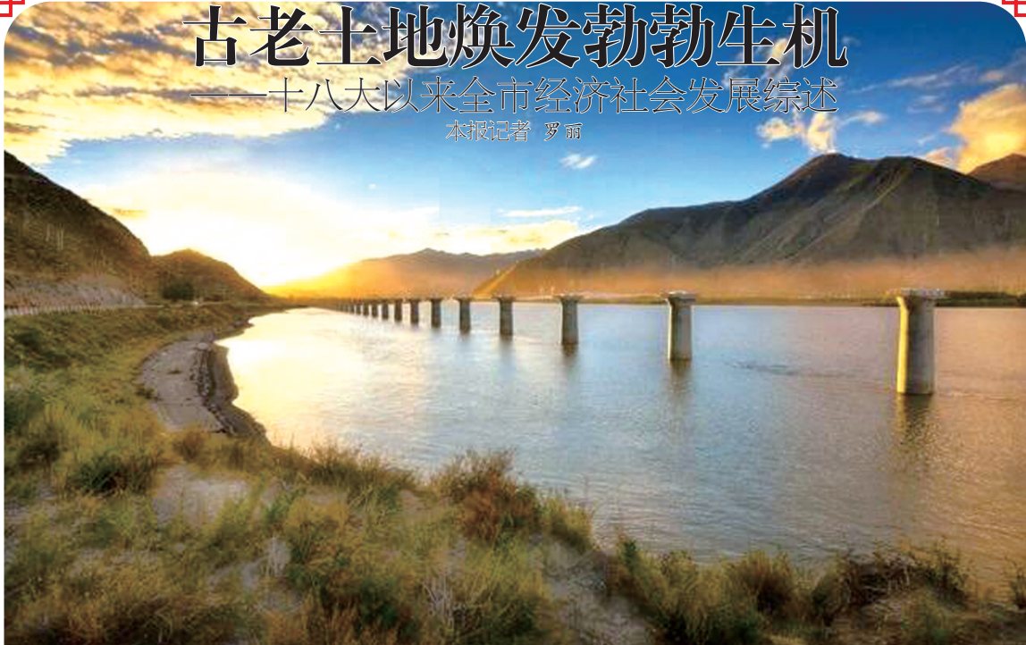
图为正在建设中的拉林铁路明则特大桥。
